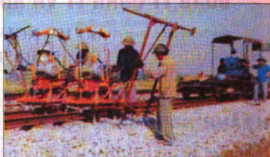
Sử dụng máy chèn đường duy tu bảo dưỡng đường sắt
