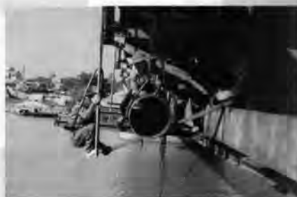
Thi công ống cấp nước treo D 600MM qua cầu rào
