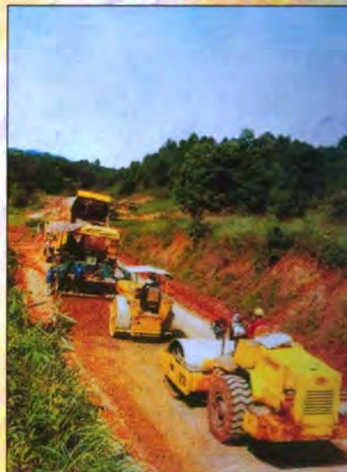
Dây chuyển thi công Asphalt đường TP. Vientiane
