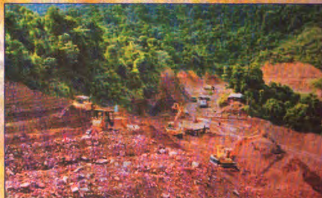
Thi công đường Hồ Chí Minh
