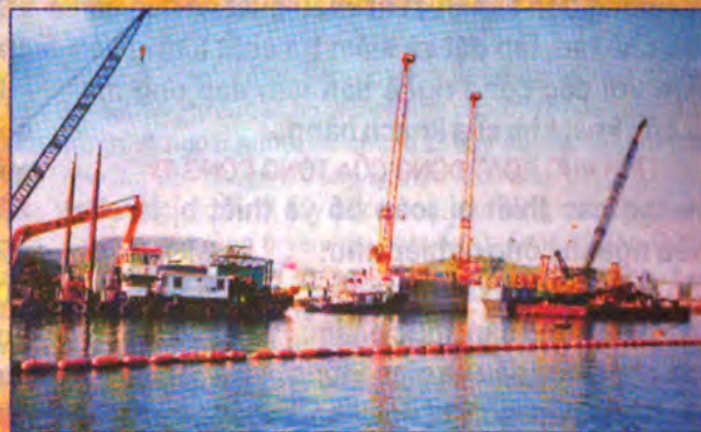
Thi công cảng Cái Lân (Quảng Ninh)
