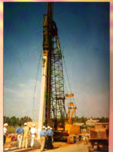
Đóng cọc, xử lý nền móng cầu quốc lộ 18 Bắc Ninh
