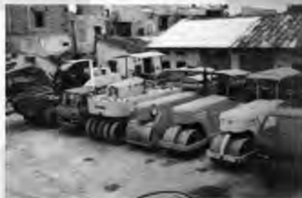
Thiết bị xe máy phục vụ thi công các công trình giao thông và cấp thoát nước
