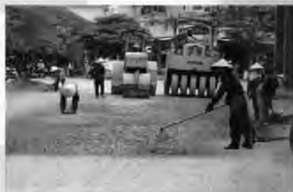
Thi công mặt đường nội thành bằng công nghệ nhũ tương nhựa đường
