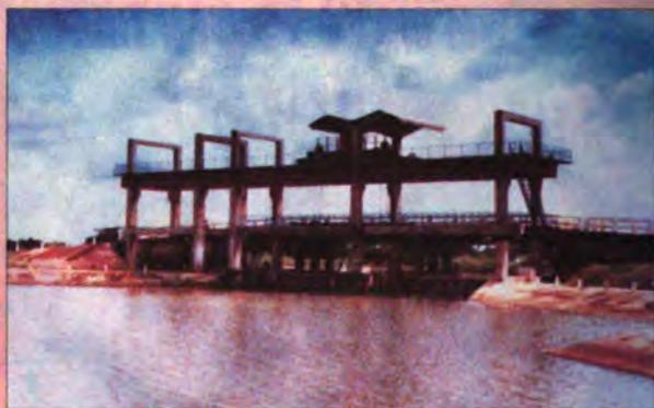
Cửa tự động hai chiều cống kênh C - TP. Hồ Chí Minh một trong những công trình Công ty thi công
