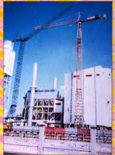
Thiết bị cầu - chuyển thi công Nhà máy Xi măng Sao Mai - Hà Tiên
