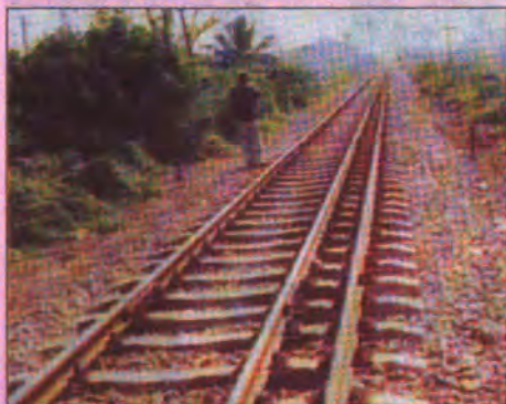
Đường Tà vẹt bê tông lổng thi công 2001
