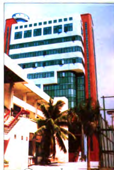
Tòa nhà giảng đường 11 tầng mới khánh thành và đưa vào sử dụng năm 2002
