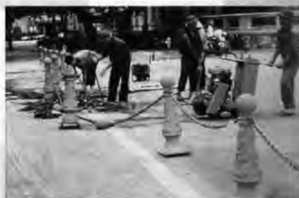
Lắp đặt dải phân cách mềm đường giao thông
