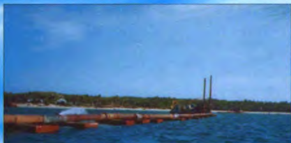
Tàu xén thổi 2400 CV nạo vét ở đảo Phú Quý - Bình Thuận, địa chất công trình là san hô cổ kết phun xa 1500m, thi công trong điều kiện biển thường xuyên có sóng gió cấp 4.
